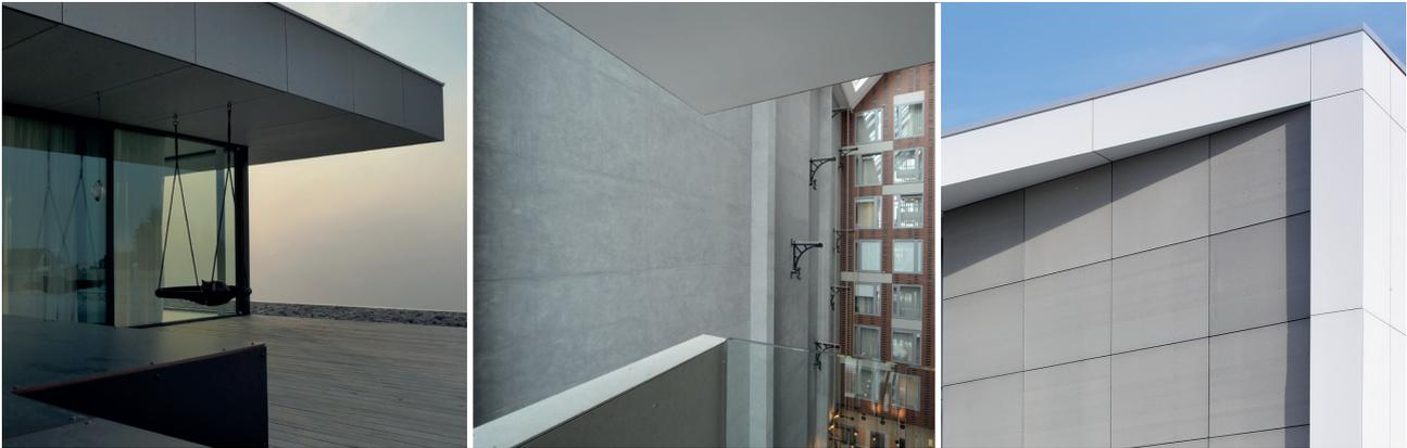
Mit der natürlichen Optik des rohen Faserzements: Construction Bautafeln aus Faserzement sind naturbelassene Faserzementtafeln in einem authentischen Grauton. Im Außenbereich eignen sie sich hervorragend zur Attikabekleidung, für Trennwände, Giebel- und Unterschlagsbekleidungen sowie verlorene Schalung. Das Material zeichnet sich durch seine Widerstandsfähigkeit und Anwenderfreundlichkeit aus und hält auch extremen Witterungsbedingungen stand. Ob Hitze, Kälte
