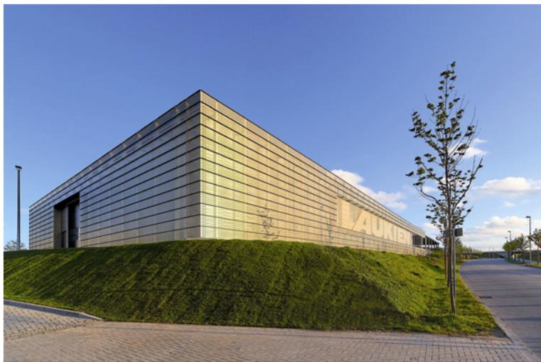
*Vorgehängte Fassade aus gelochten Aluminiumpaneelen, Produktionshalle Laukien in Kiel.*
