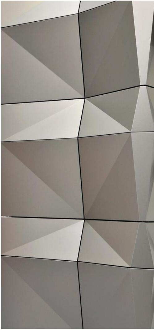
*Durch die Weiterverarbeitung von ALPOLIC™ Verbundtafeln für die Fassade wird bei diesen Elementen eine besondere plastische Optik erzielt.*
